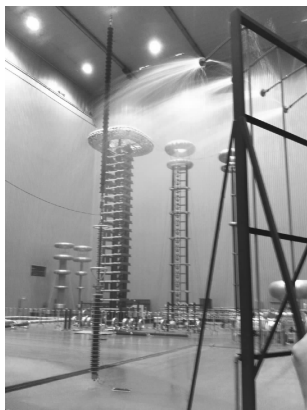
图6 线路避雷器湿耐压试验现场照片
